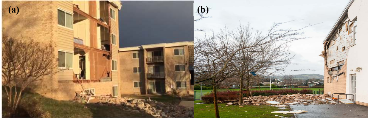
Şekil 4. (a) ABD'de şiddetli rüzgarda meydana gelen duvar hasarı [7] (b) İskoçya'da fırtına sonrası duvar hasarı [8]
